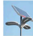
illuminazione esterna a pali led alimentati da celle fotovoltaiche
