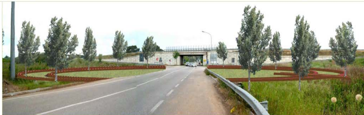
Vista del bacino idrico all'ingresso da via S.Vito
