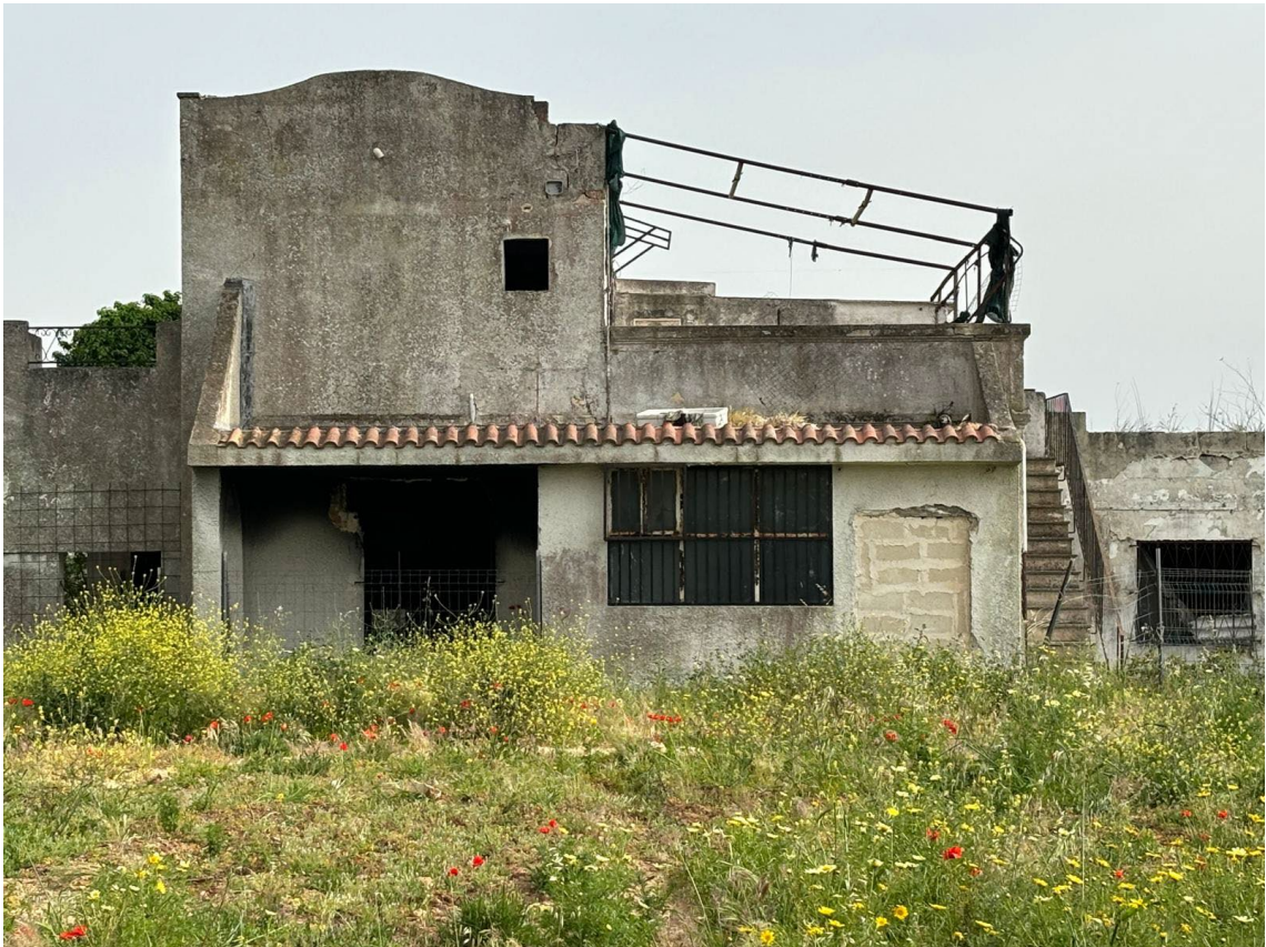
Figura 10 Fabbricato da demolire proprietà Rinascente di Puglia S.r.l.
