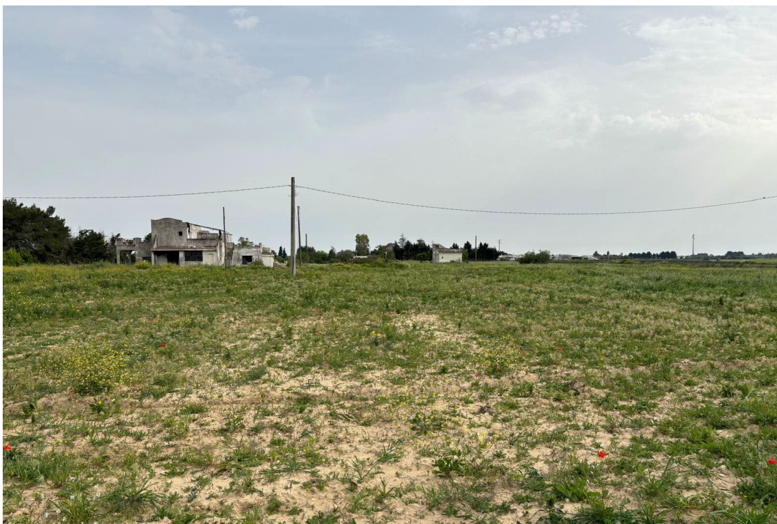
Figura 6 Area di progetto con fabbricato da demolire proprietà Rinascente di Puglia S.r.l.
