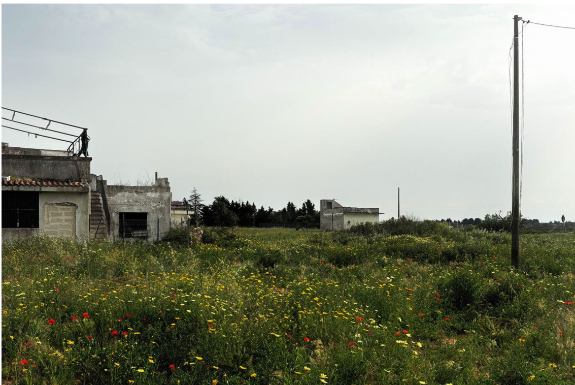
Figura 9 Fabbricati da demolire
