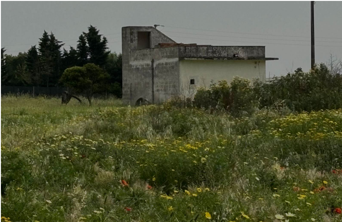
Figura 8 Fabbricato proprietà De Punzio - Gallo da demolire
